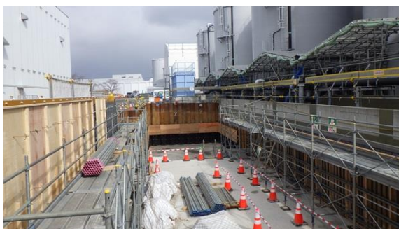
(写真1-1) 外堰拡張工事の状況
