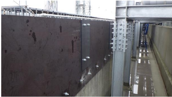
(写真 2 - 2) 外堰かさ上げ工事の状況② ※堰の内から撮影
