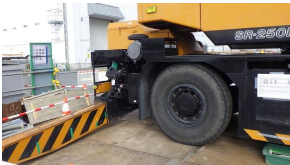
(写真 3 - 1) クレーンの設置状況
