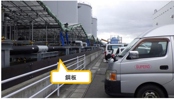
(写真 2 - 1) 外堰かさ上げ工事の状況① ※堰の外から撮影
