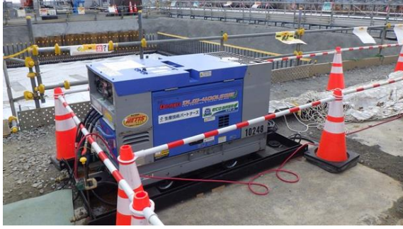
(写真 3 - 3) 溶接機の設置状況
