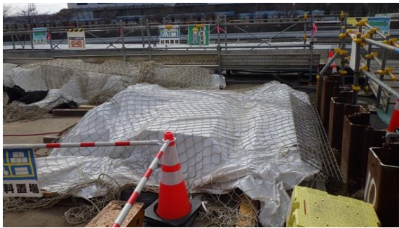
(写真 4) 資機材の仮置き状況
