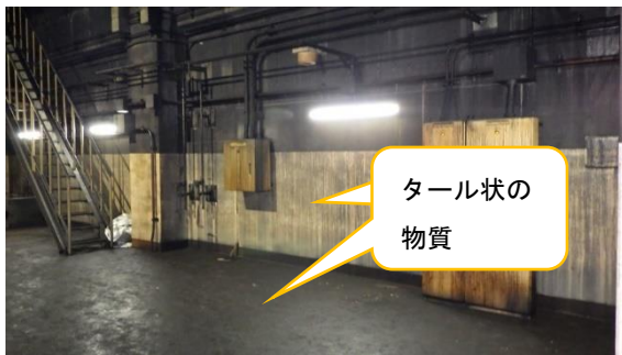
(写真2) 廃棄物供給室の床、壁面の状況
