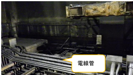
(写真3-1) 廃棄物供給室内の設備機器の状況①
