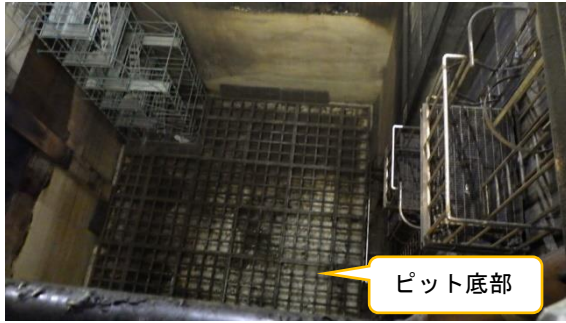
(写真1) ピット内の状況
