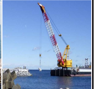
海上からのブロック設置状況
