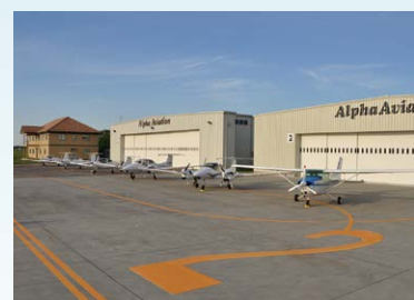
民間航空機操縦訓練施設 パイロットの養成を目的とした訓練施設です。
