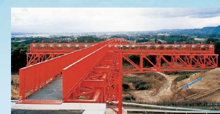
簡易式進入灯(SALS) 非精密進入によって着陸しようとする航空機に、その最終進入の経路を示すための灯火です。L=153m
