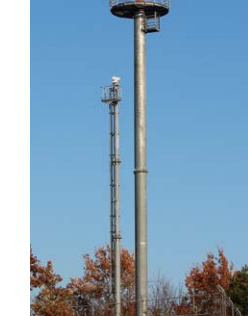
飛行場灯台(ABN) 飛行中の航空機に飛行場の位置を示すための灯火です。
