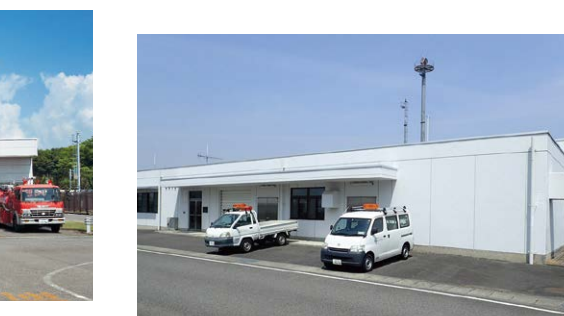
電源局舎 航空灯火に給電するための電源設備を収容する建物で、停電時に給電可能な発動発電機等も装備しています。
