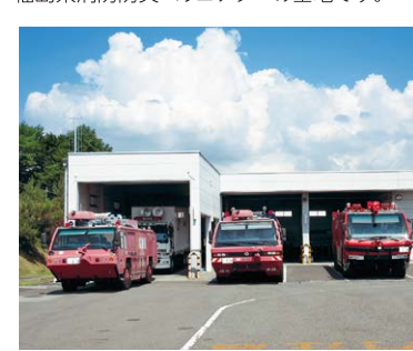
消防車庫 航空機に事故・火災が発生したとき、これを消火する車輛を格納しておく建物で、大型化学消防車(12,500ℓ台)(10,500ℓ台)(6,100ℓ台)と給水車(8,000ℓ台)、医療用搬送車(1台)を配備しています。
