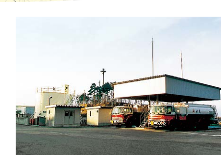
給油施設(POL) 航空機に給油するジェット燃料を扱っており、200kℓタンク1基を有しています。
