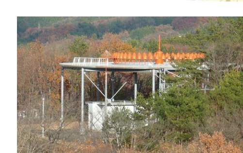
VOR/DME 飛行中の航空機に方向と距離を知らせる施設です。
