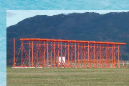
ローカライザー(LOC) 着陸のため進入中の航空機に対して滑走路中心の左右のずれを電波によって示す装置です。
