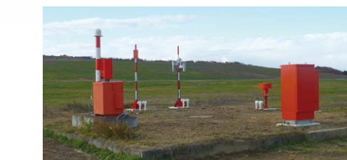
露場・雲高観測装置 気温・露点温度・降水量及び雲低の高さを測定する装置です。
