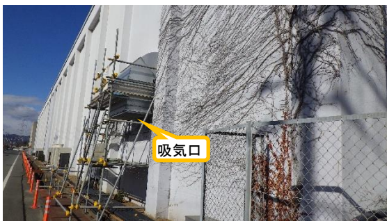
(写真 5) 定検機材倉庫B 建屋南東側に設置さ れている吸気口の状況 (西側から撮影)
