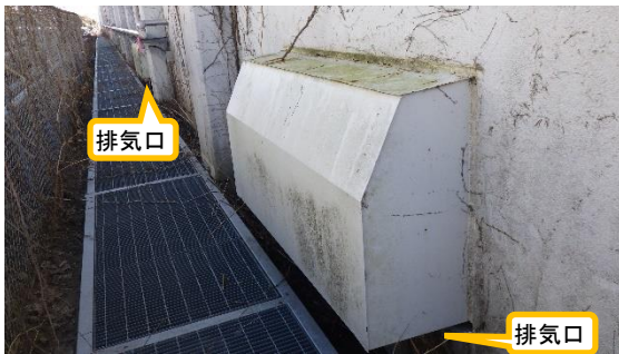
(写真 4) 定検機材倉庫B 建屋北側壁面沿いに 設置されている排気口の状況 (西側から撮影)
