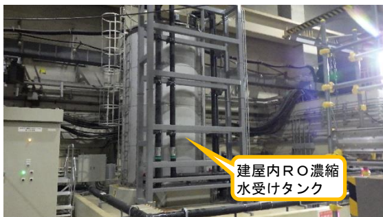
(写真 1 - 4) 建屋内RO濃縮水受けタンクの設置状況
