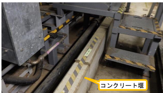
(写真 2 - 1) コンクリート堰の設置状況
