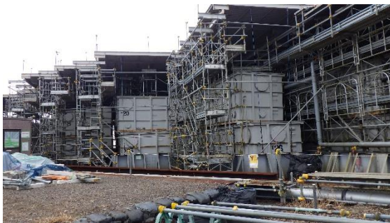
(写真1-1) D排水路の集水エリア① (瓦礫類一時保管エリアNの外観)
