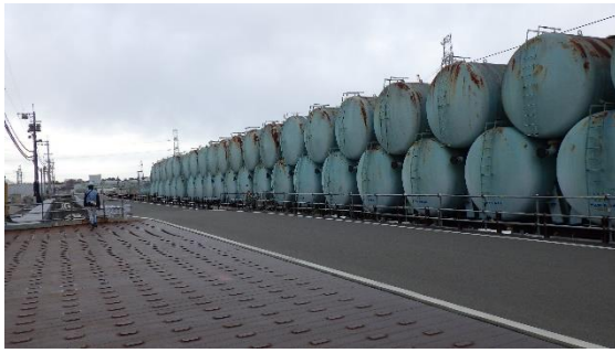
(写真 2-1) D排水路の集水エリア③ (横型ブルータンク保管エリアCの 外観)
