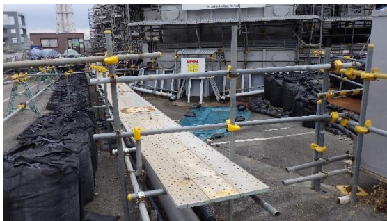
(写真1-2) D排水路の集水エリア② (瓦礫類一時保管エリアNのうち 凹地付近)
