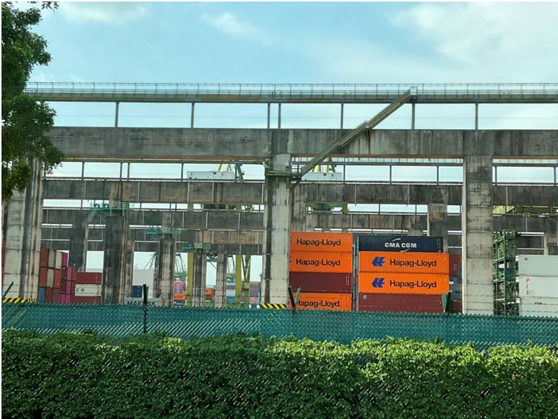
【 コンテナヤードの様子 】
