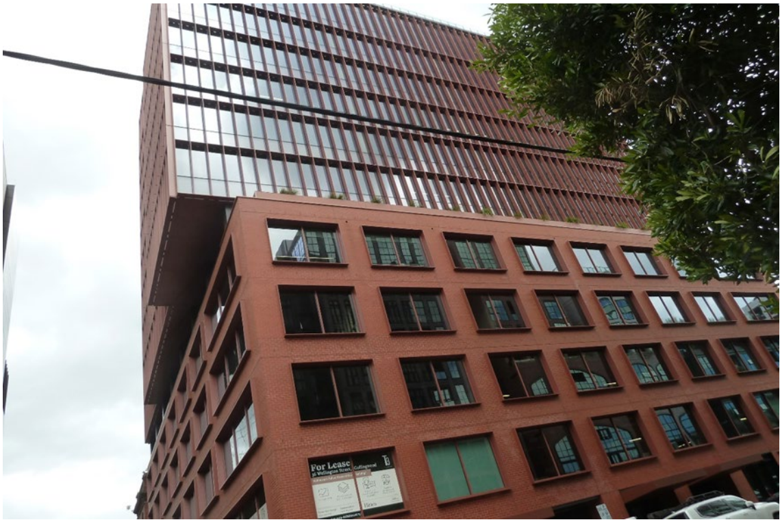
【 調査したビルの外観（6階までが鉄筋コンクリート造、7階からが木造） 】
