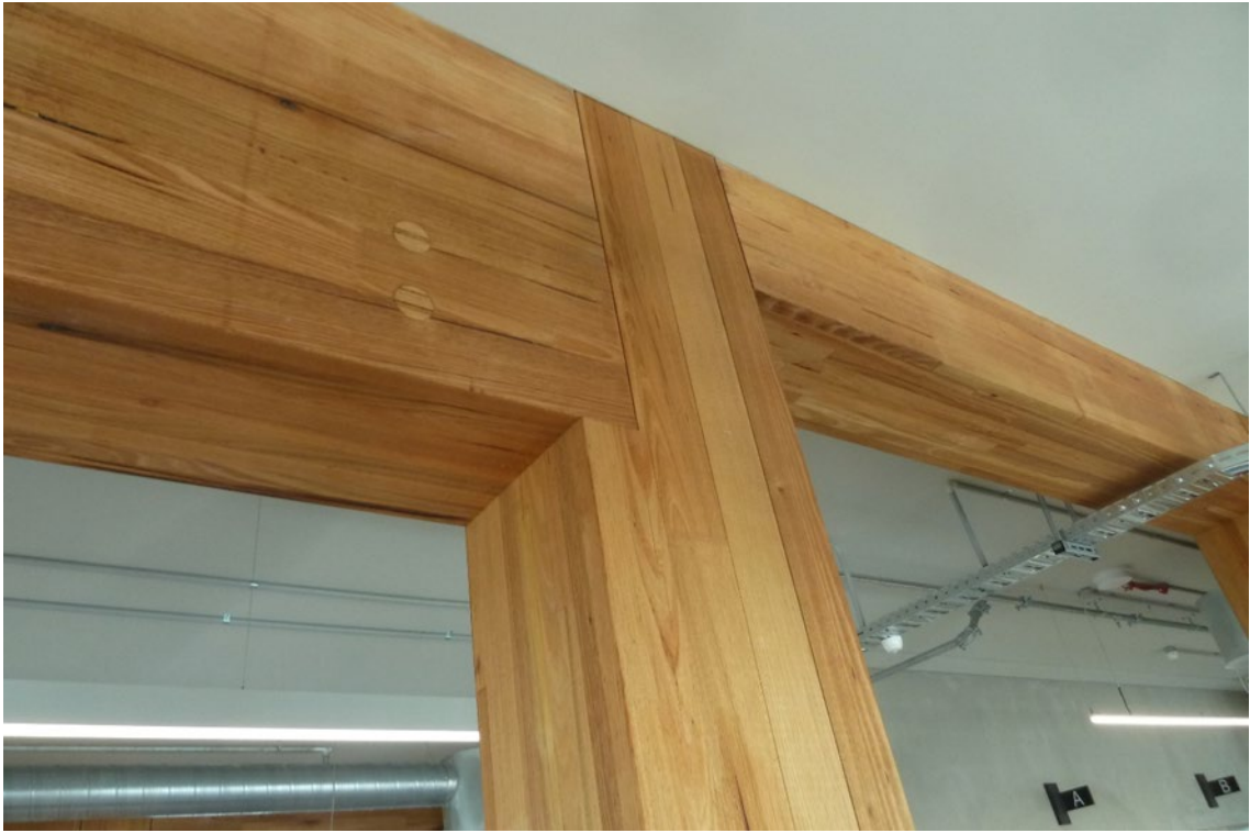
【 接合部の様子 】
