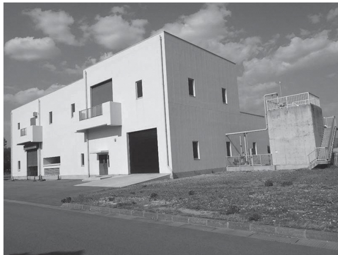
第2スクリーンポンプ棟(工事中)
