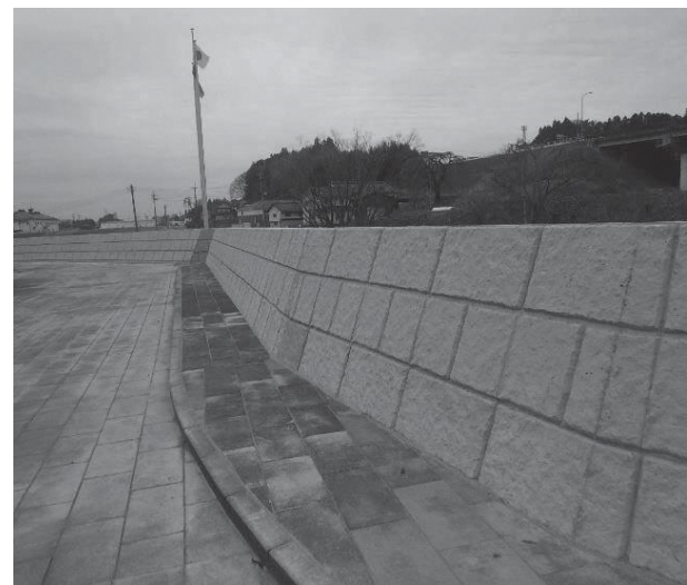
あだたら清流センター擁壁工
