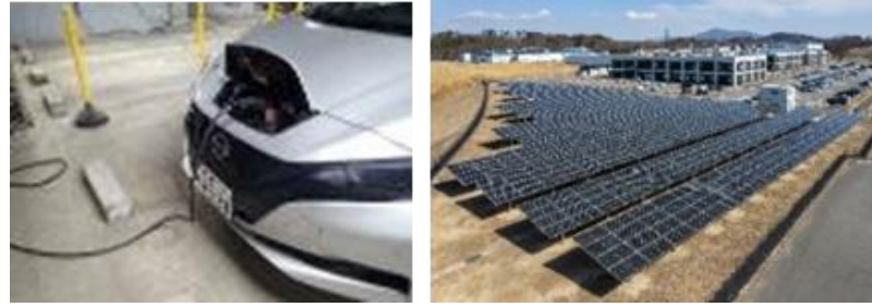
EVや充電設備の整備、太陽光発電設備の導入
