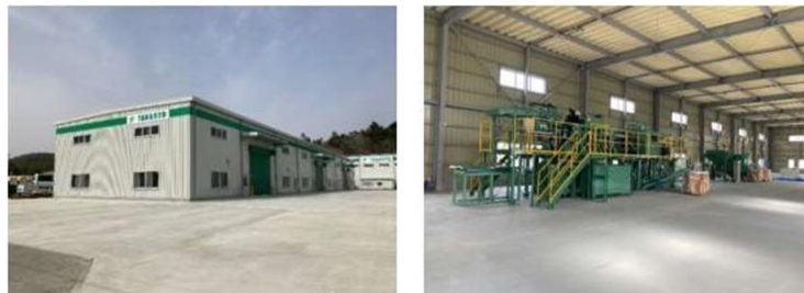
太陽光パネルリサイクル施設（提供：(株)高良）
