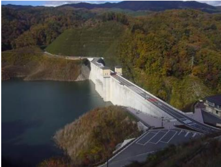
木戸ダム（楡葉町）
