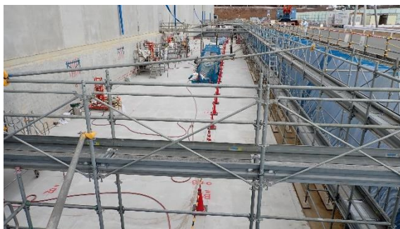
(写真1③) 地盤改良工事の状況
