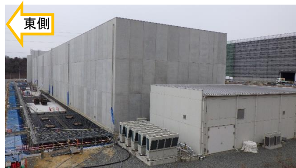
(写真1②) 保管庫外観 (北側)
