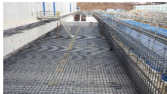
(写真2①) 基礎スラブ増設工事の状況
