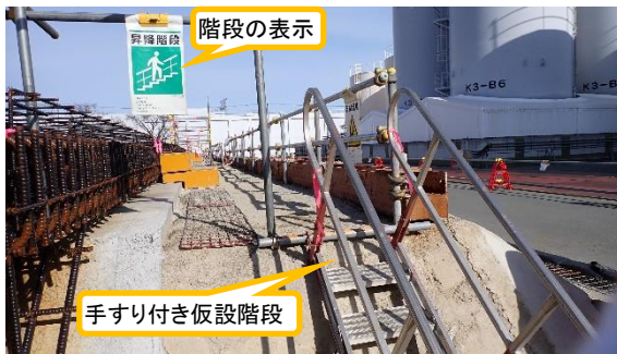
(写真3) 安全対策の実施状況
