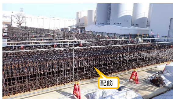
(写真1-2) 敷地東側拡張工事の状況 (南西側から撮影) (令和7年1月27日撮影)
