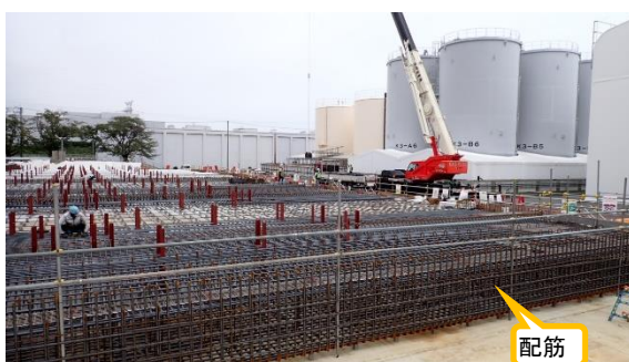
(写真1-1) 敷地東側拡張工事の状況 (南西側から撮影) (令和6年10月1日撮影)
