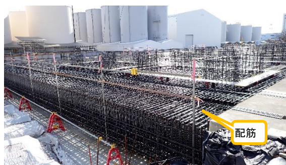
(写真1-4) 敷地東側拡張工事の状況 (北西側から撮影) (令和7年1月27日撮影)
