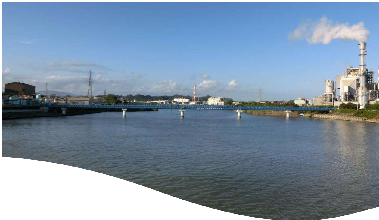
藤原川 みなと大橋上流
