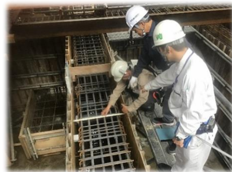
工事監理（配筋検査）
