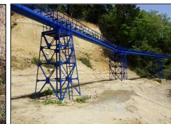
【復旧完了】 （新たに製作据付）
