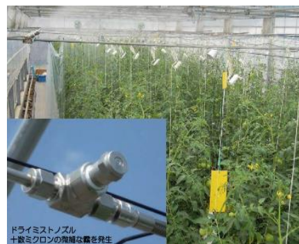
ドライミストノズル 十数マイクロンの微細な霧を発生 ミスト冷房による高温対策
