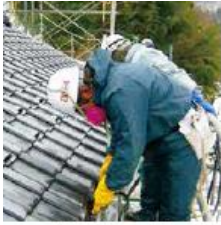
▲ Entseuchung von Wohngebäuden (Entfernung von Ablagerungen)
