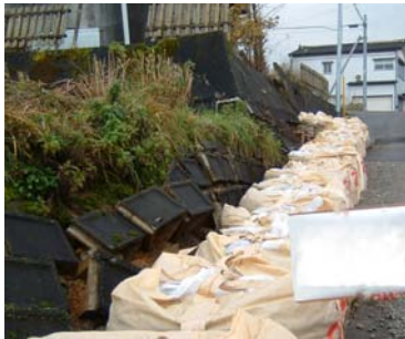
土嚢積みによる擁壁崩壊の抑制
