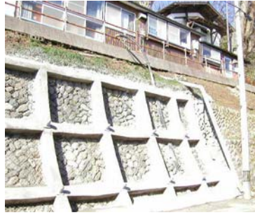
写-6.1 擁壁の仮復旧
