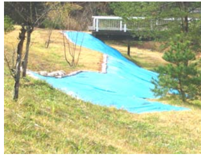
シートによる斜面の防護
