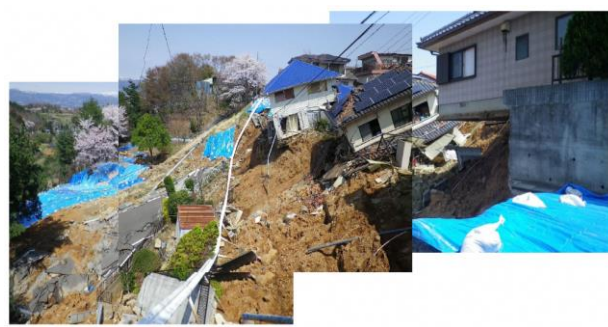
(d)液状化による側方流動
