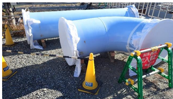
(写真2②)取り外された配管
