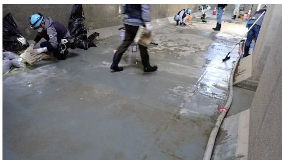
(写真1①)補修作業の状況
