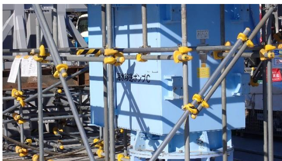
(写真2①)取り外された海水移送ポンプ
