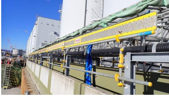
(写真3) タンクエリア周辺設備の保護状況
