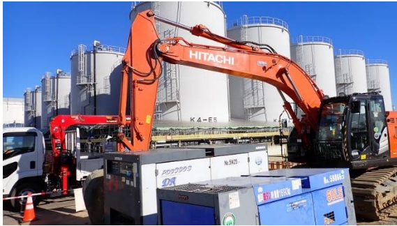
(写真4) 重機の設置状況
