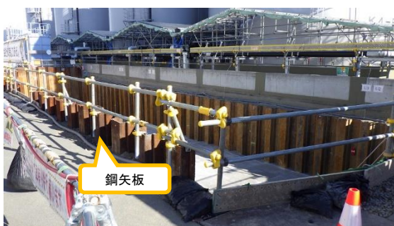
(写真1) 外堰拡張工事の状況
