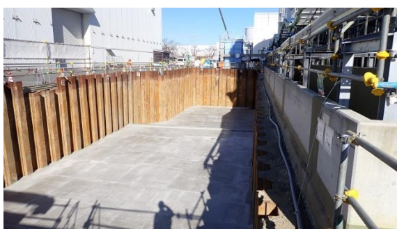
(写真2) 拡張された外堰内部の状況
