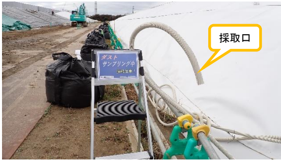
(写真 2 - 1) ダストサンプリング中を示す標示 及び採取口の状況
