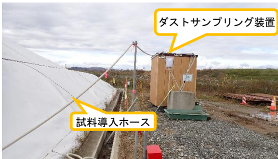
(写真 2 - 2) ダストサンプリング装置の設置状況 及び試料の吸引状況
