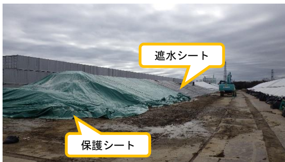
(写真1-2) 第4槽の状況② (第1層の遮水シート・覆土撤去が完了し、第2層目の遮水シートが露出。同シートを剥がした部分には、保護シートにより養生中)
