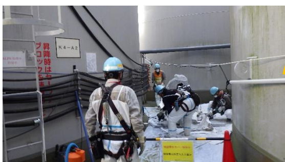
(写真1) B群タンク内残水を移送用の専用車を用いてC群タンクへ移送
