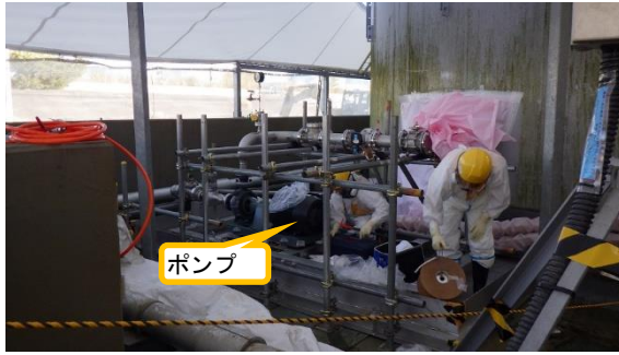
(写真3) ポンプの設置作業の状況
