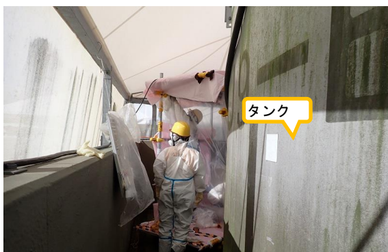
(写真 2) 装備交換所（仮設ハウス）設置作業 の状況
