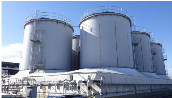
(写真4) J8タンクエリア外観
