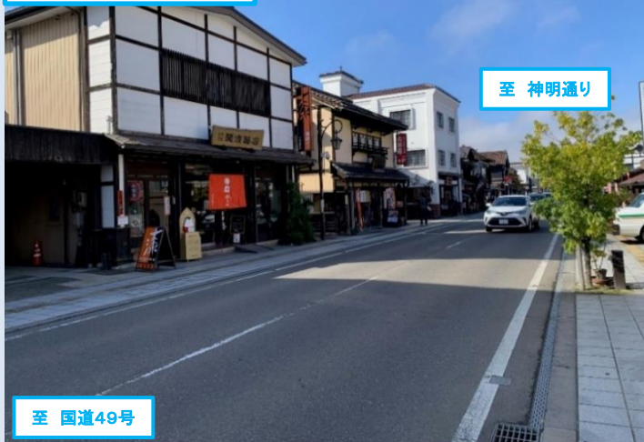
施工後・下の区
