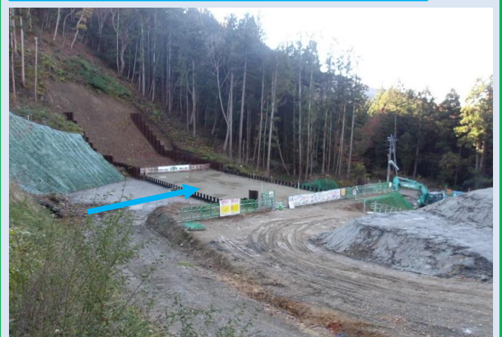
本堤基礎工施工状況(令和6年11月末時点)
