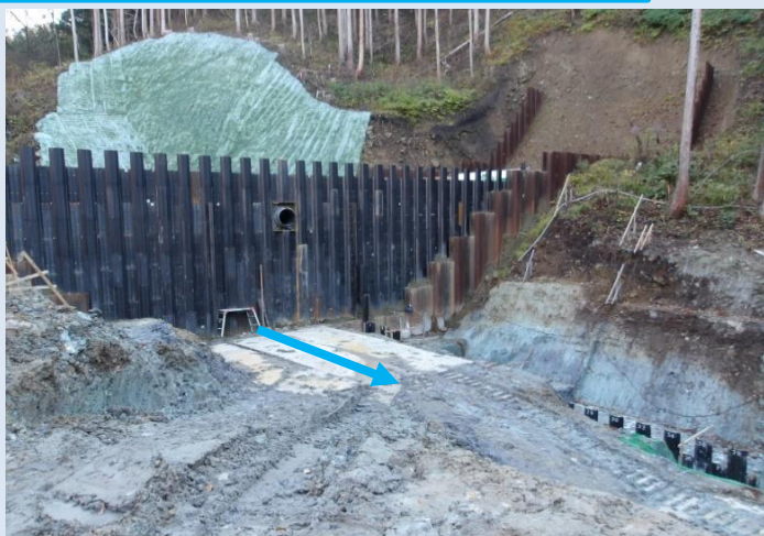
本堤基礎工施工状況(令和6年11月末時点)
