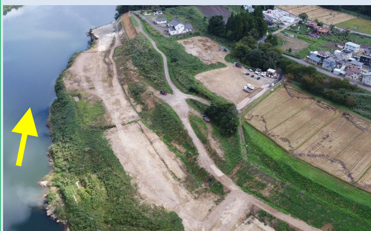
施工中（令和6年10月末時点）
