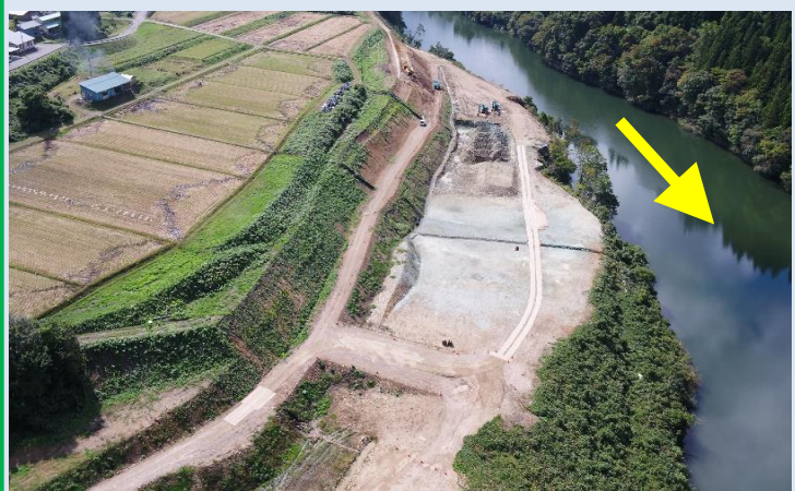
施工中（令和6年10月末時点）
