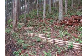
移動抑制対策(筋工)
