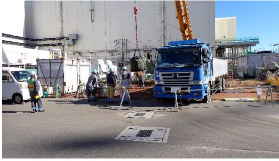
(写真2) 撤去した干渉物を収納したフレコン バックの仮置き状況
