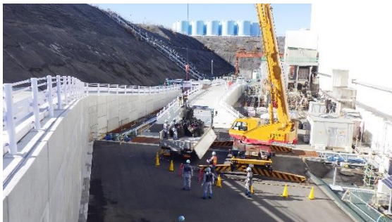
(写真1-2) 撤去した干渉物を収納したフレコン バックの輸送車両への積載作業の状 況
