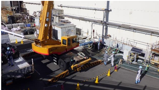
(写真1-1) 撤去した干渉物を収納したフレコン バックの吊り上げ作業の状況
