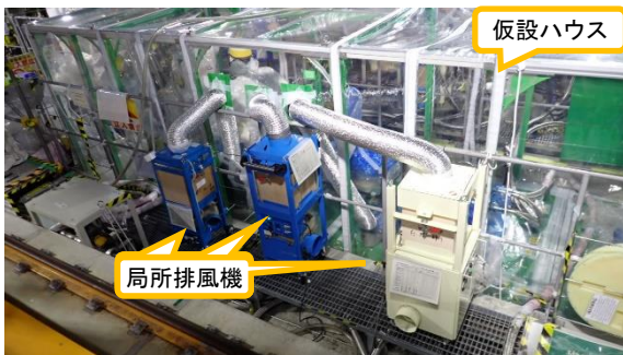
(写真 2 - 3) 局所排風機の設置状況
