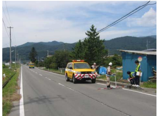
道路の異常を点検している様子
