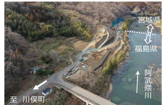
国道349号 五十沢工区 (伊達市梁川町)
