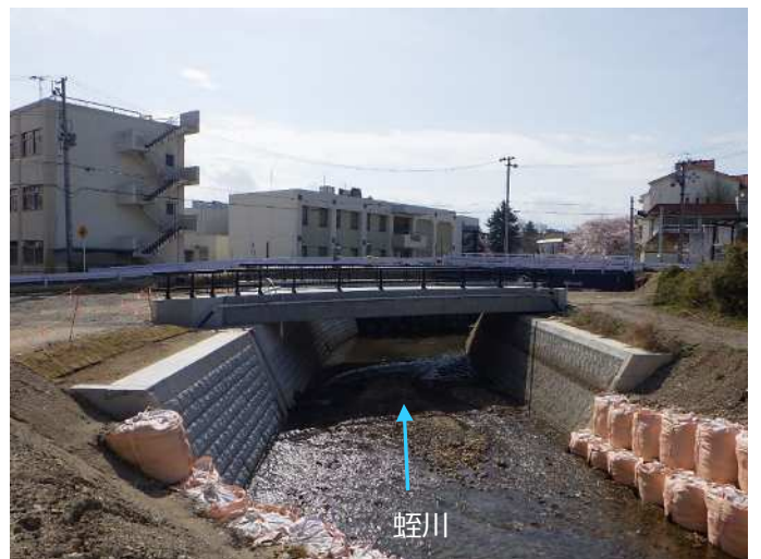
蛭川（福島市瀬上町）田尻橋仮橋撤去
