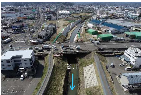
濁川（福島市鳥谷野） 堤防整備状況
