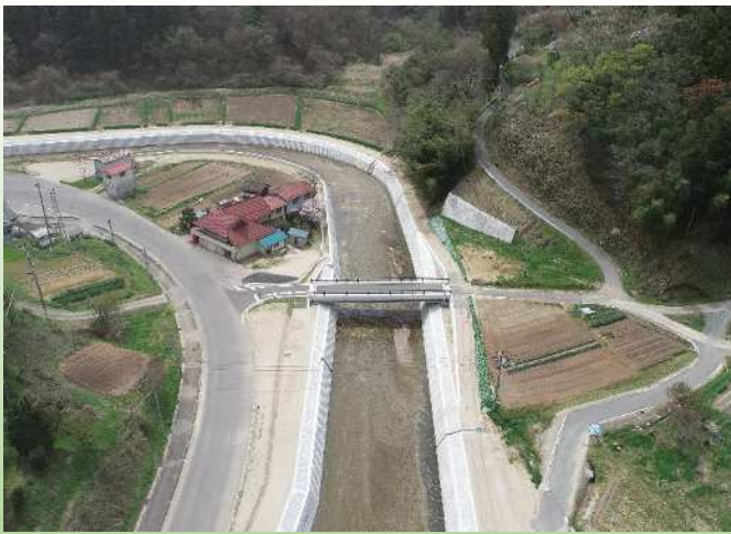
【令和元年台風からの改良復旧工事】 安達太田川
