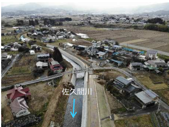
佐久間川（伊達郡桑折町） 橋梁施工状況
