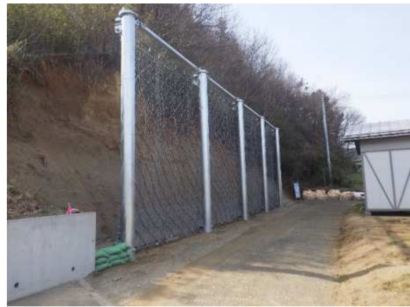
崩壊土砂防護柵工施工中（柏崎地区） [川俣町東福沢]
