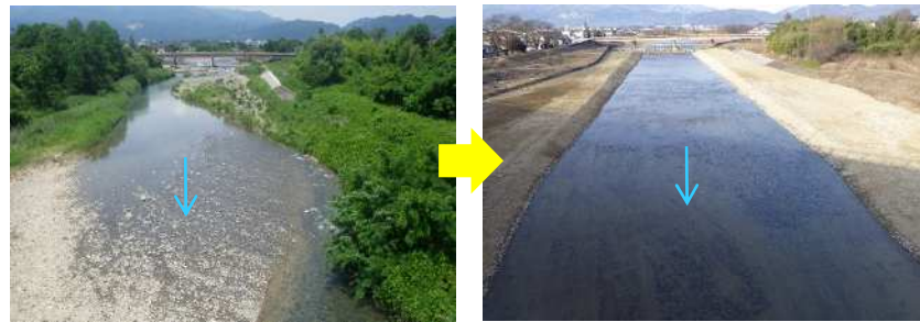
施工前 施工後 松川（福島市）※R5年度実施
