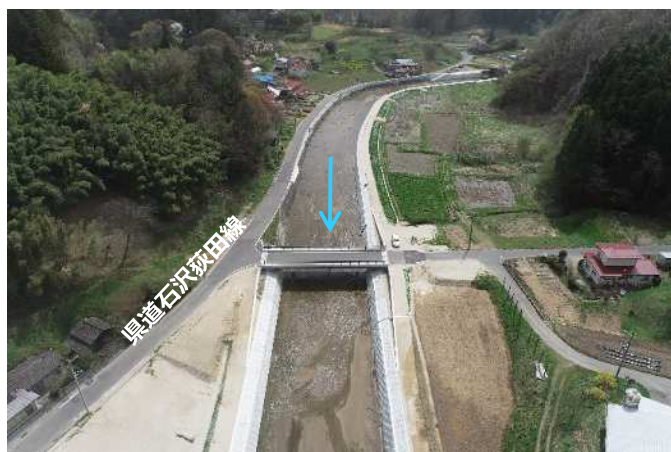
安達太田川（二本松市太田） 護岸整備状況
