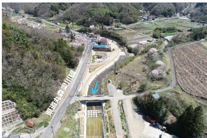
山舟生川（伊達市梁川町山舟生） 護岸整備状況
