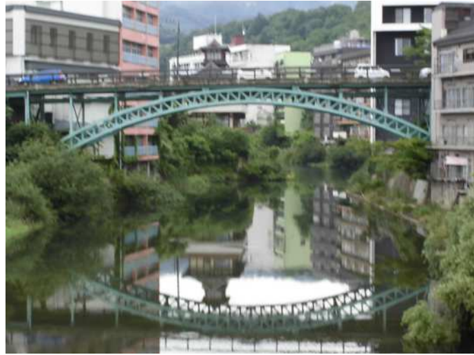
土木学会選奨土木遺産 & 国登録有形文化財に指定された十綱橋（福島飯坂線・福島市）
