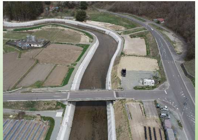
【令和元年台風からの改良復旧工事】 移川3工区
