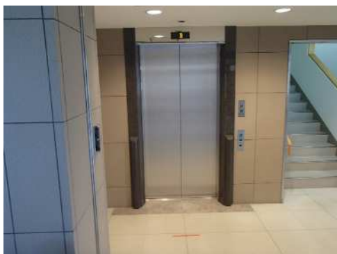
昇降機の改修 《自治研修センター（福島市）》
