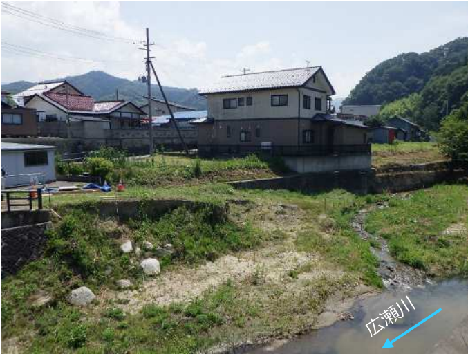
広瀬川（伊達郡川俣町川原田） 改修前状況
