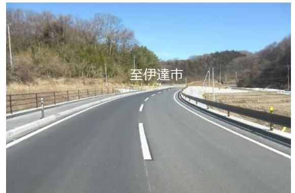
国道349号 杉沢工区 (二本松市)
