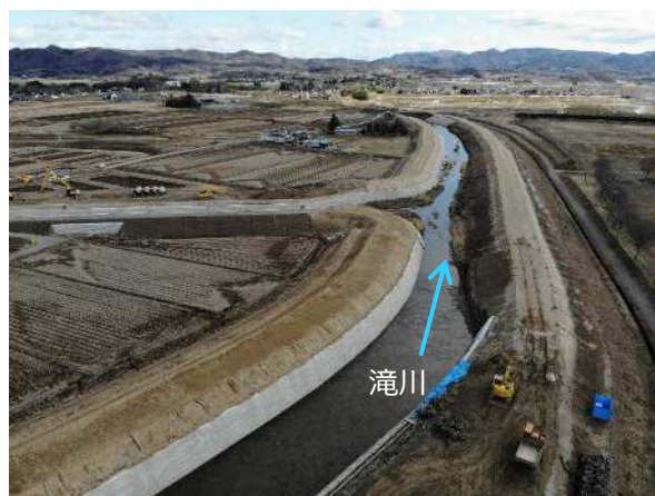
滝川（伊達郡国見町） 堤防整備状況
