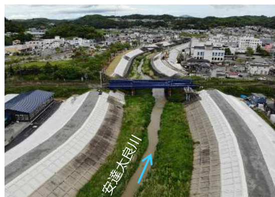
安達太良川（本宮市本宮） 堤防整備状況
