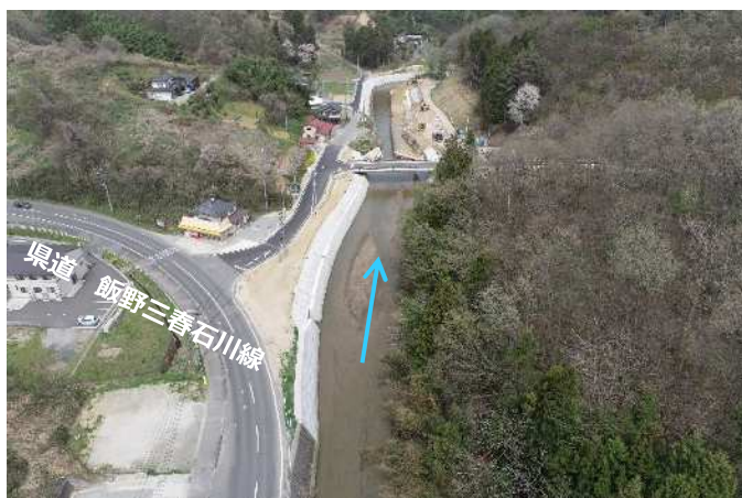
移川（二本松市上長折） 護岸整備状況
