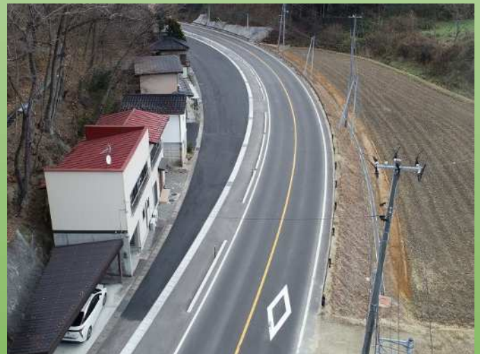
【狭小部の拡幅道路】 国道459号 沼ヶ作工区
