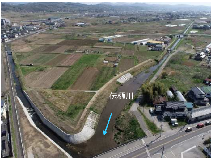
伝樋川（伊達市梁川町）橋梁工
