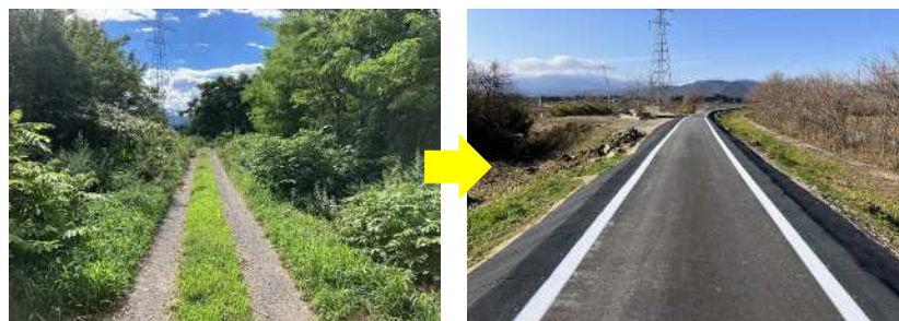
施工前 施工後 摺上川（福島市）※R5年度実施
