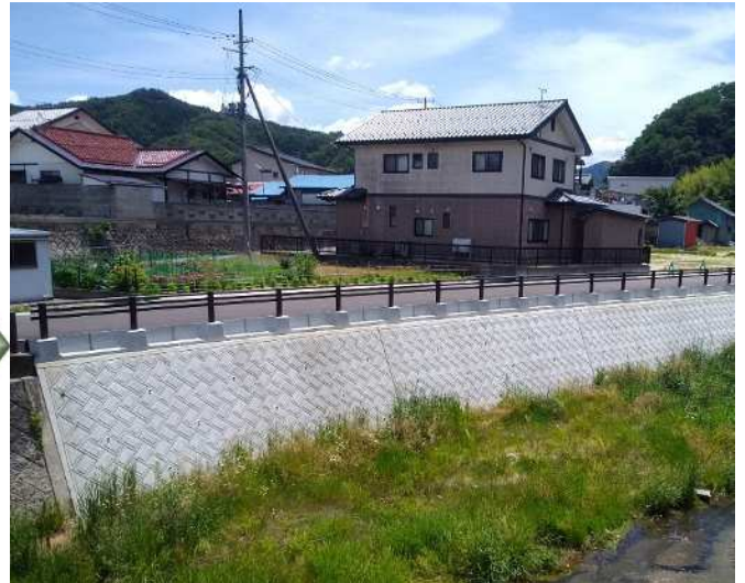
広瀬川（伊達郡川俣町川原田） 整備完了箇所
