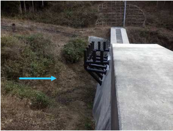
R5流木対策工完了（七曲の沢筋） [川俣町七曲]
