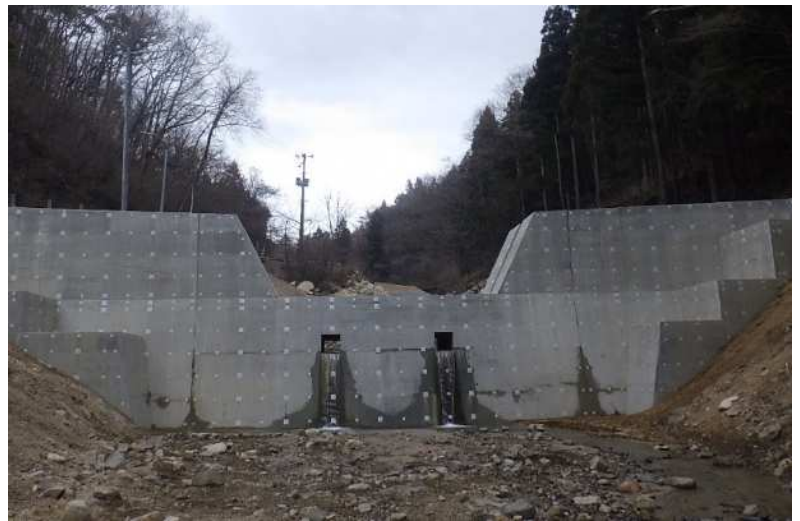
山舟生川砂防えん堤（梁川町）
