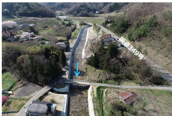
広瀬川（川俣町小島）護岸整備状況
