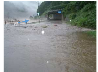
館岩川から溢水した水は国道まで達した
