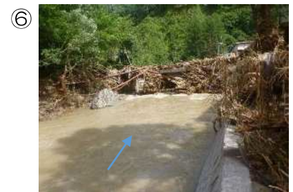
⑥ 新田橋上流側から見た流木の状況
