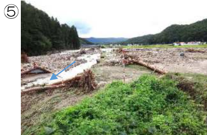
⑤ 金井沢地内 越水による破堤及び背後地の浸水痕跡
