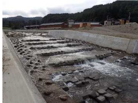
(桧沢川4号床止完了)
