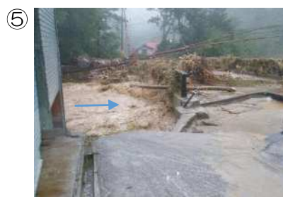
⑤ 9/10 朝の新田橋の状況
