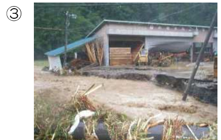
③ 木材工場の浸食被害
