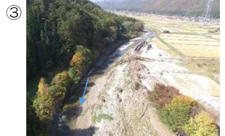
③ 塩江地内 背後地への土砂流入状況（ドローン撮影）
