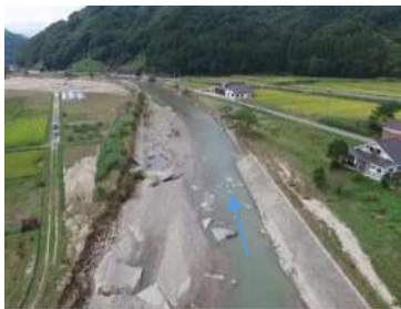
館岩川の越水による破堤及び土砂流入状況(ドローン撮影)
