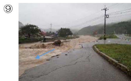
⑨ 静川地内 高橋に流木が引っ掛かり落橋
