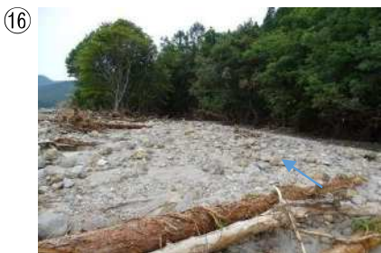
⑯ 針生地内 流出土砂により河道閉塞が生じた
