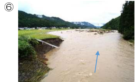
⑥ 金井沢地内 越水による破堤及び背後地の浸水状況
