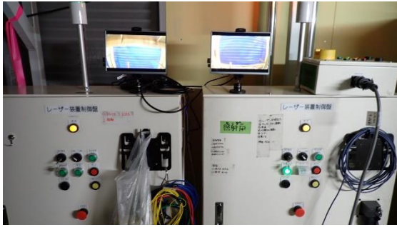
(写真2) レーザー照射装置の設置状況
