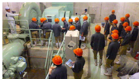
▲「新宮川ダム」農業用ダム管理
