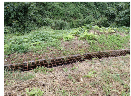
▲ワイヤーメッシュ柵を敷設したところ
