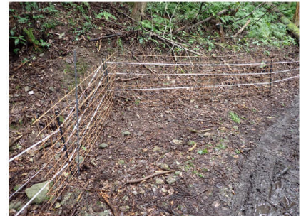
▲リボンワイヤーを設置したところ
