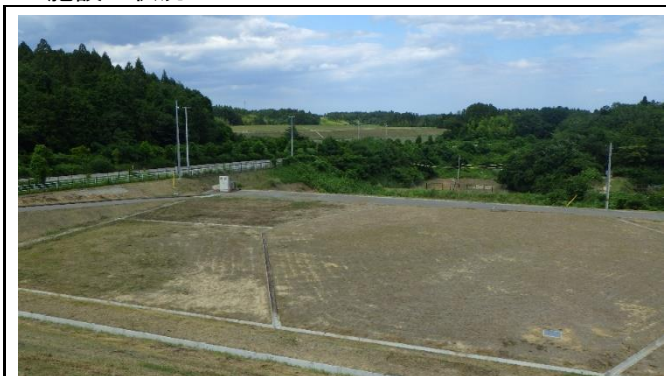
土壌貯蔵施設の状況（令和4年9月貯蔵完了） 異常なし。
