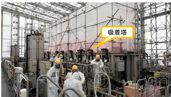
(写真2-1) 吸着塔の計装品校正作業の状況
