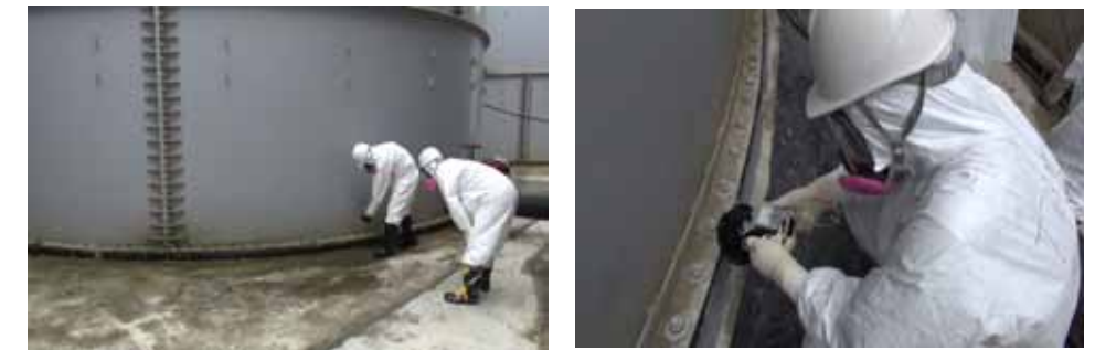
福島第一原子力発電所 H4タンクエリアパトロールの様子 (2013年9月12日撮影)
