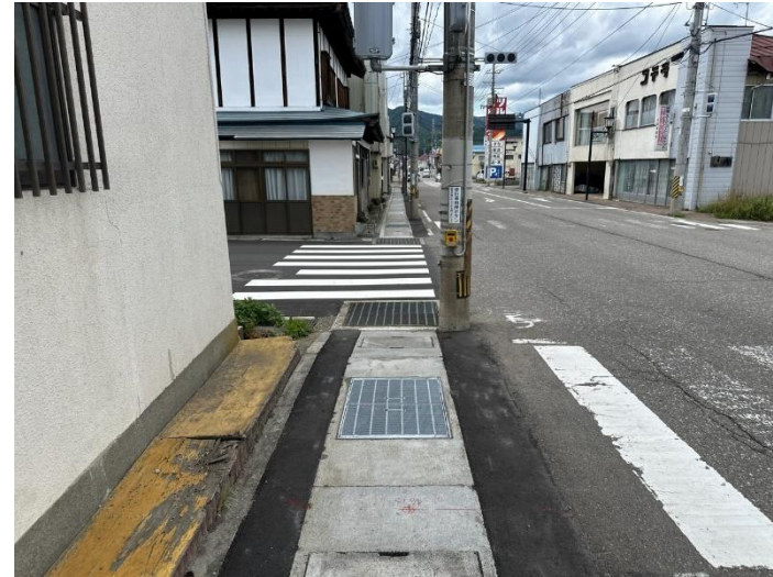
R6工事完了後
