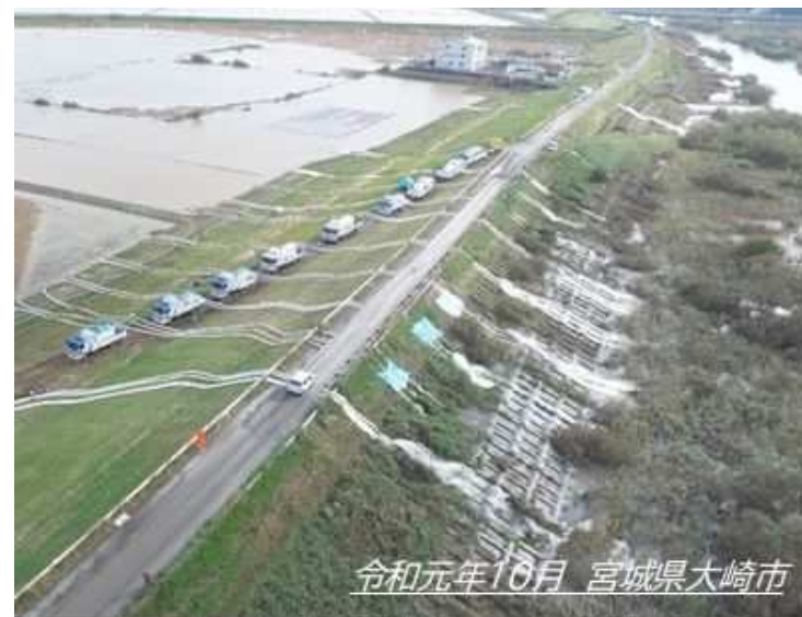
令和元年における排水ポンプ車の稼働状況（国土交通省HPより）
