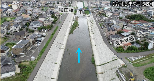
③ 咲田橋から東部幹線(市施行)までの区間 【令和6年7月撮影】
