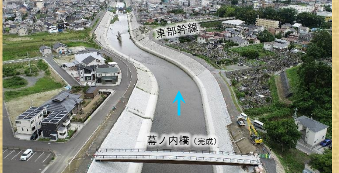
④ 東部幹線から幕ノ内橋までの区間 【令和6年7月撮影】
