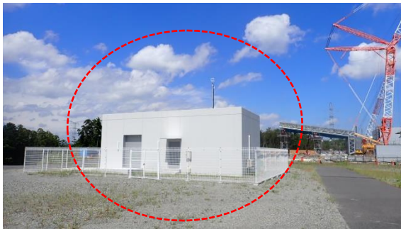
(写真 2 - 2) 新設気象観測設備の現在状況② (気象観測設備のデータ収集建屋が あり、機器類保管場所も確保)
