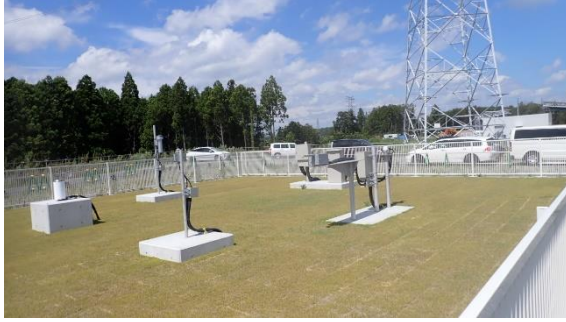
(写真 2 - 1) 新設気象観測設備の現在状況① (周辺監視区域外の 1F 構外駐車場 西側ランニングコース内に設置。)
