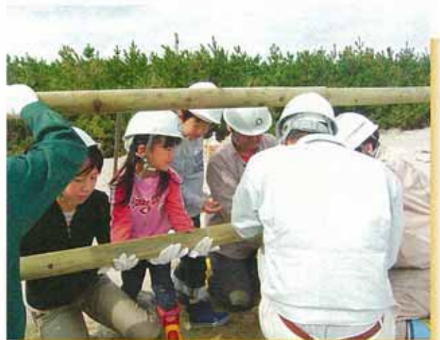
侵入防止柵の設置 いわき市
