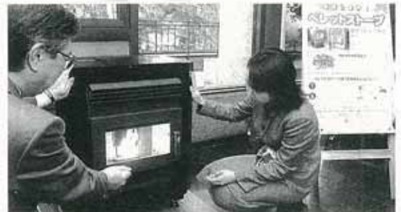
県庁の県民ホールに設置されたペレットストーブ
