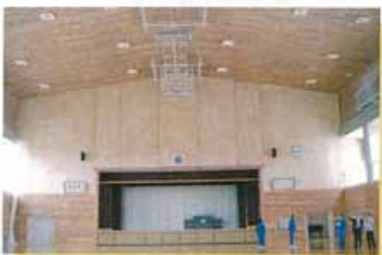
間伐材による公共施設の内装木質化 会津坂下町
