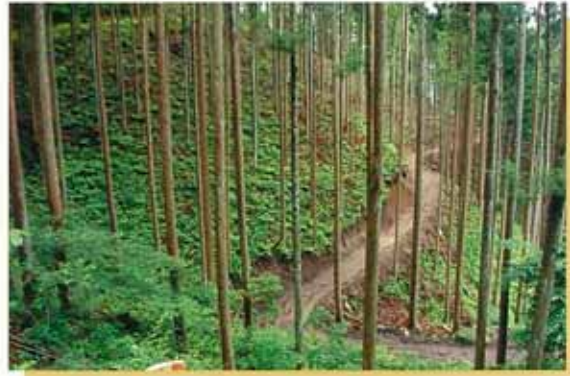
作業路開設 田村市
