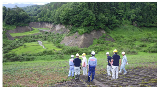
▲二岐ダム現地調査の様子
