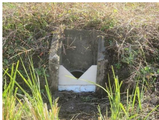
田んぼダム取組効果観測業務で設置した排水調整堰板
