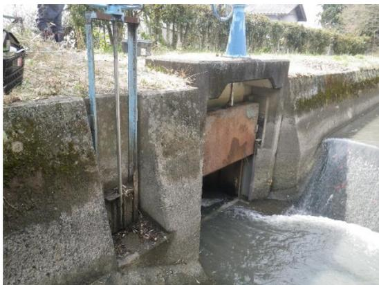
水門整備補修（開閉機電動化、扉体交換）
