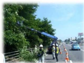
道路支障木伐採
