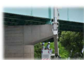
阿久津橋 点検状況
