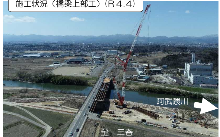
施工状況（橋梁上部工）（R4.4）
