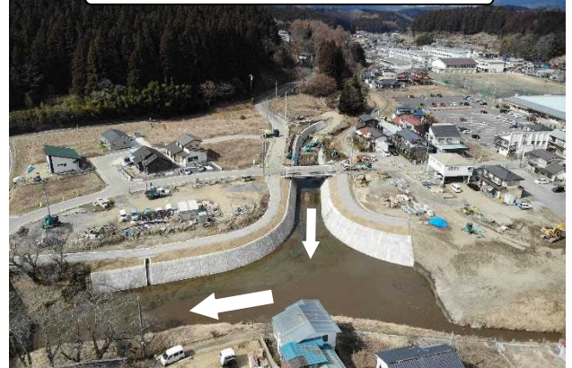
現場状況：車川の改修状況(R 4.3)
