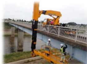
横塚橋 点検状況
