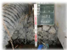
沢又橋 カゴマット中詰状況
