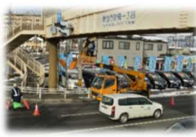
あさか歩道橋 点検状況
