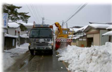
除雪（排雪）中状況
