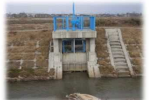
南川放水路 南川水門
