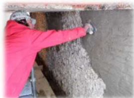
沢又橋 断面修復状況
