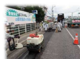
舗装修繕（パッチング）
