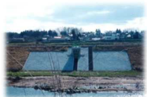
谷田川 江下3号樋門
