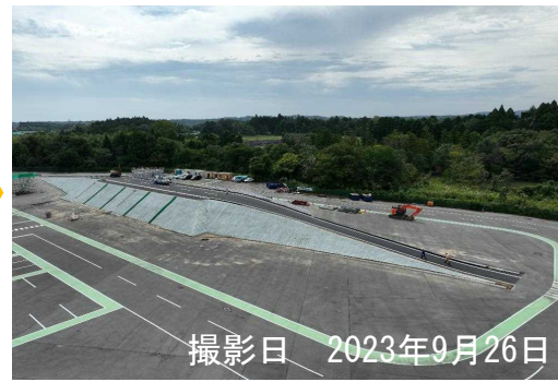
路面排水・舗装・法面工
