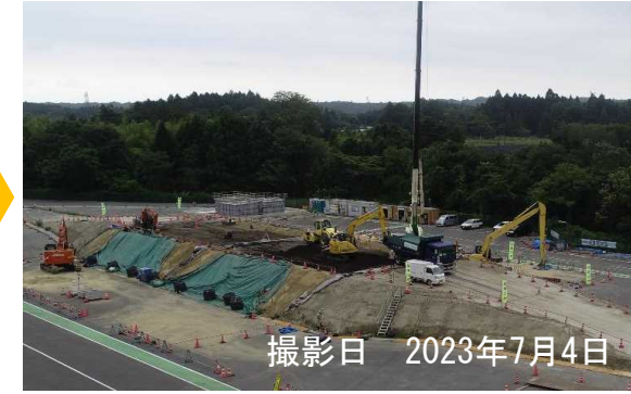
路体盛土工（路体11層目）
