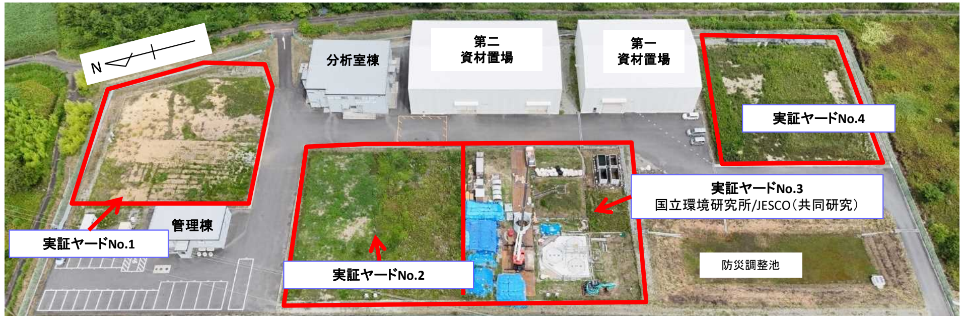
ドローンによる技術実証フィールド全景(2024年7月2日時点)
