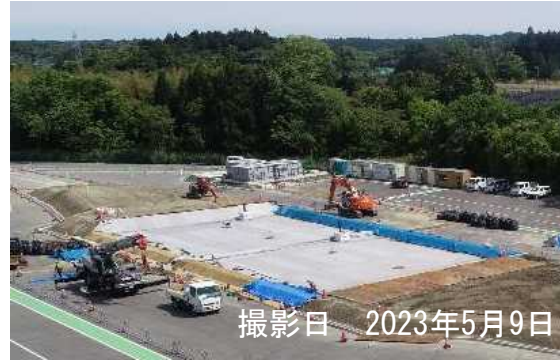
浸透水処理工（盛土底盤部）
