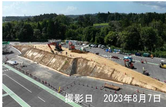
路床盛土工（覆土）
