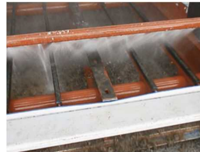
解泥後の土壌に水をかけながら、ふるいを振動させることで、主に「礫」を回収する設備
