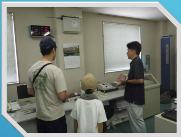
操作室での機械の説明
