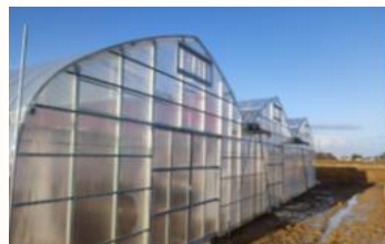
図2 建設中のハウス
