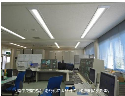
2階中央監視室：老朽化により既にLED照明に更新済。
