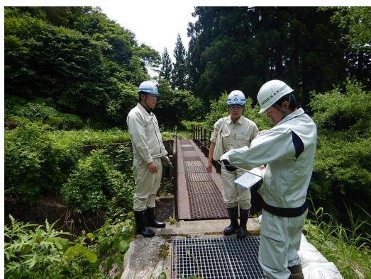
点検状況(只見町水路橋)
